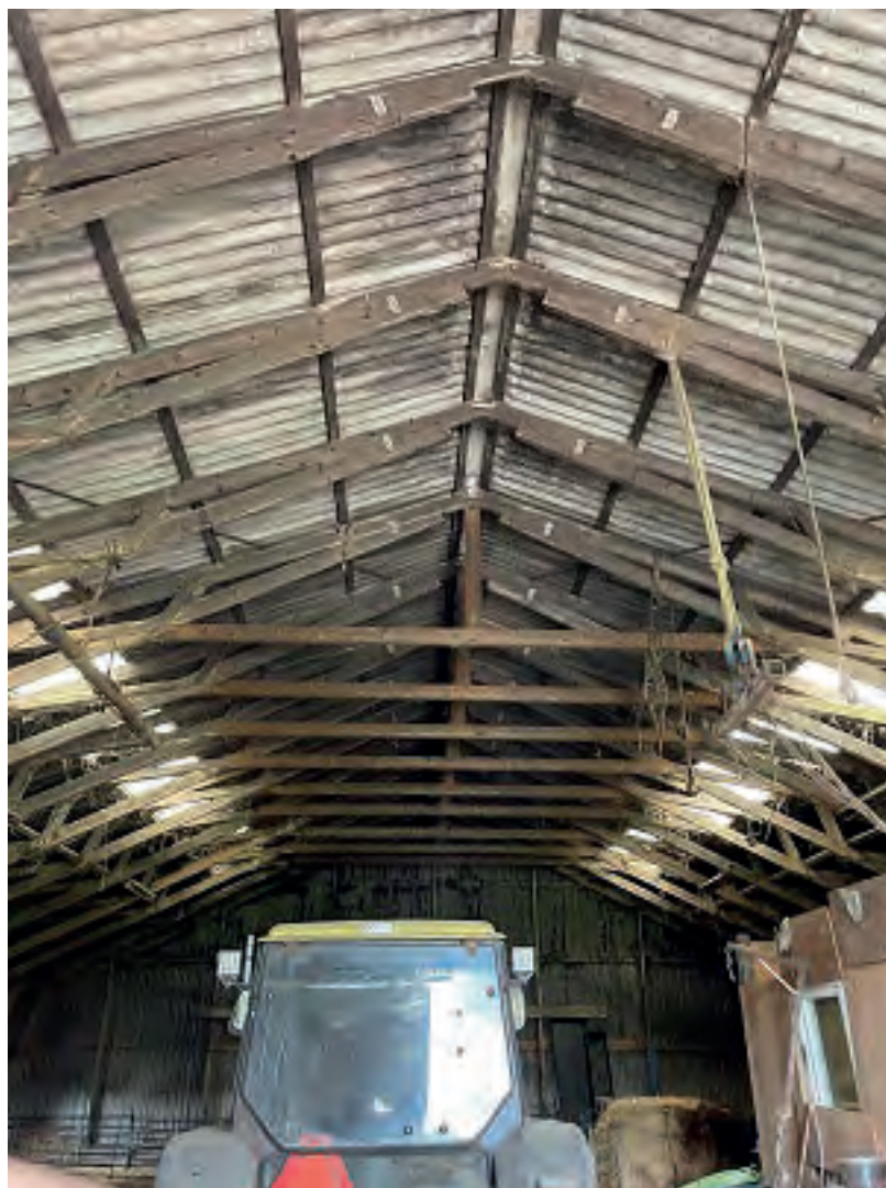
Figur 3-52 Ladebygning ved E19H
