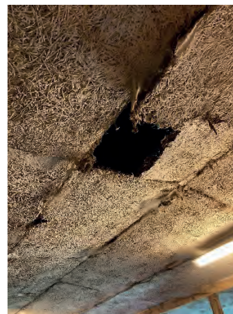
Figur 3-26 Staldbygningen havde flere huller i loft og tagkonstruktion.
