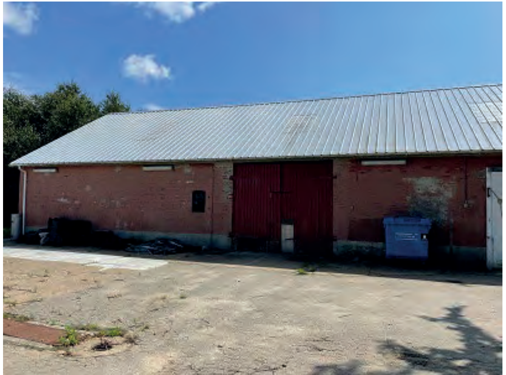
Figur 3-24 Ladebygningen har adgang under tagkonstruktionen, samt åbne staldvinduer. Foto taget i retning mod øst.
