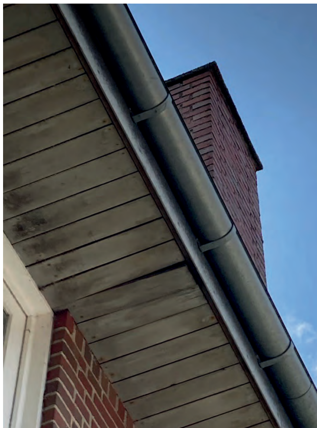
Figur 3-30 Der var løse brædder i østgavlen på E08H
