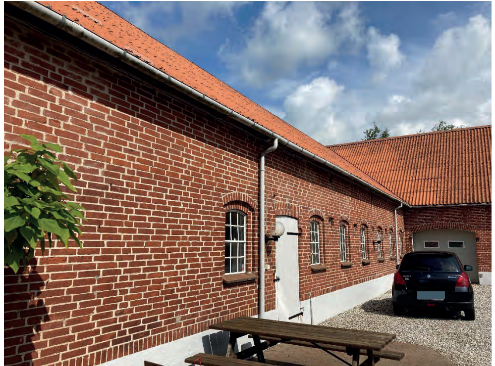
Figur 3-36 Hovedhuset har tætte vinduer og ingen sprækker langs taget
