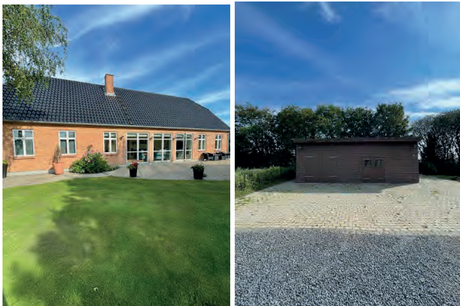
Figur 3-46 Stuehuset (tv.) og et mindre skur(th.) på grunden.
