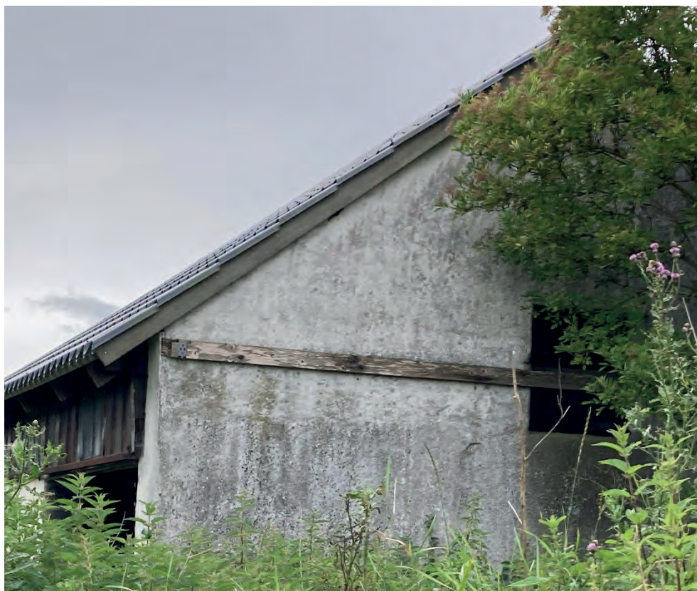
Figur 3-19 Åbning i nordlig gavl samt åben port øst i bygningen, som giver meget vind ind i bygningen.
