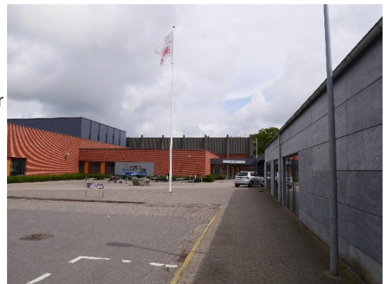
Indgangspartiet til Bramming Kultur- og Fritidscenter kunne blive mere aktivt og indbydende. Foto: COWI
